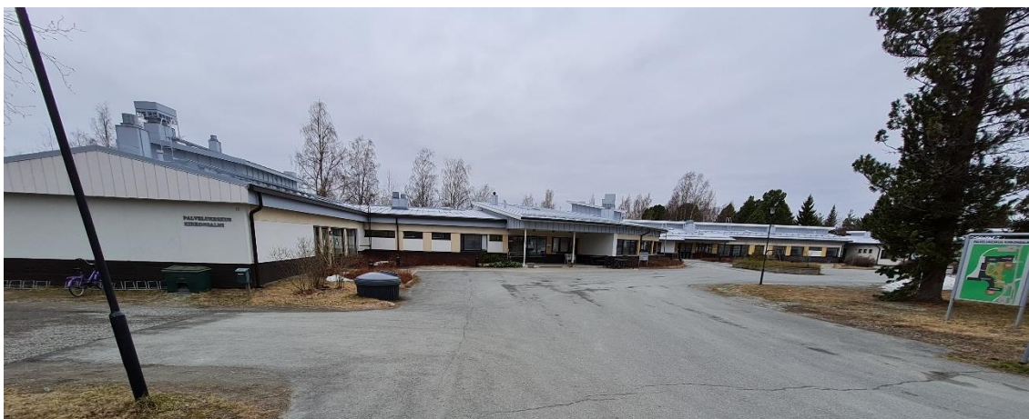
Valokuva. Kirkonsalmen Palvelukeskus, ulkopuolelta
