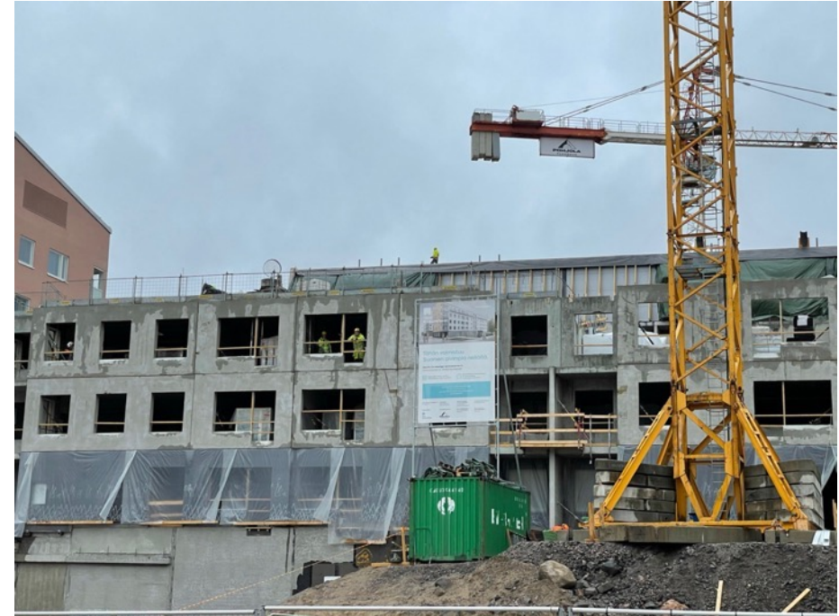
Rakennustyömaa Helsingin Kannelmäessä 20.5.2021.
